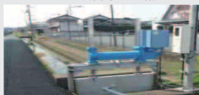
排水門の電動化
