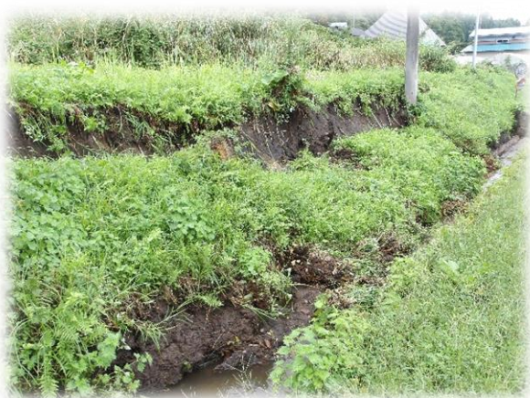
十和田地区 五軒屋幹用 4 号水路 法面崩れ・水路壁崩壊
