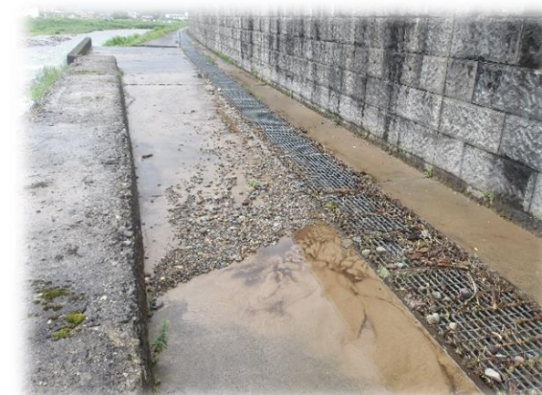
八幡平地区 西館頭首工幹用 45 号水路 土砂堆積
