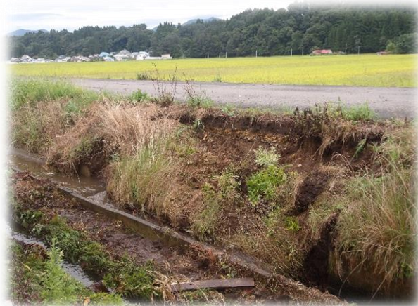
十和田地区 細谷地支用 9 号水路 法面崩れ・水路土砂流入
